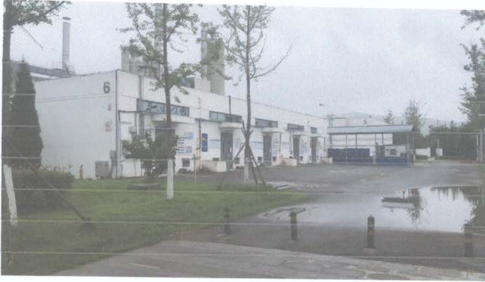
惠河路-90-6A 号控制室
