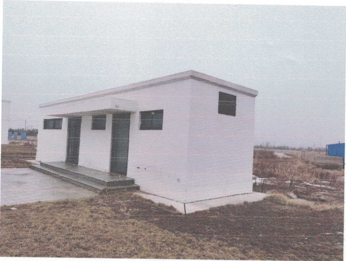
惠河路-90-18 号消防泵房
