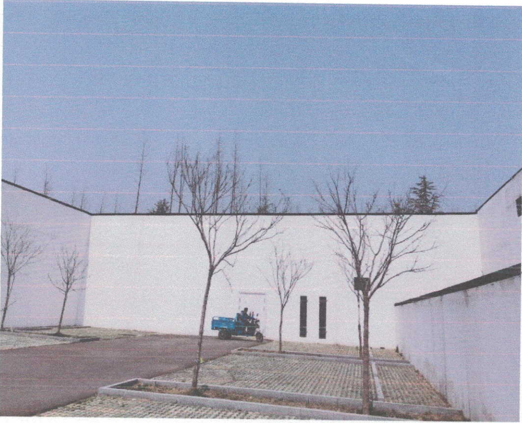
惠河路-90-29 号水泵房
