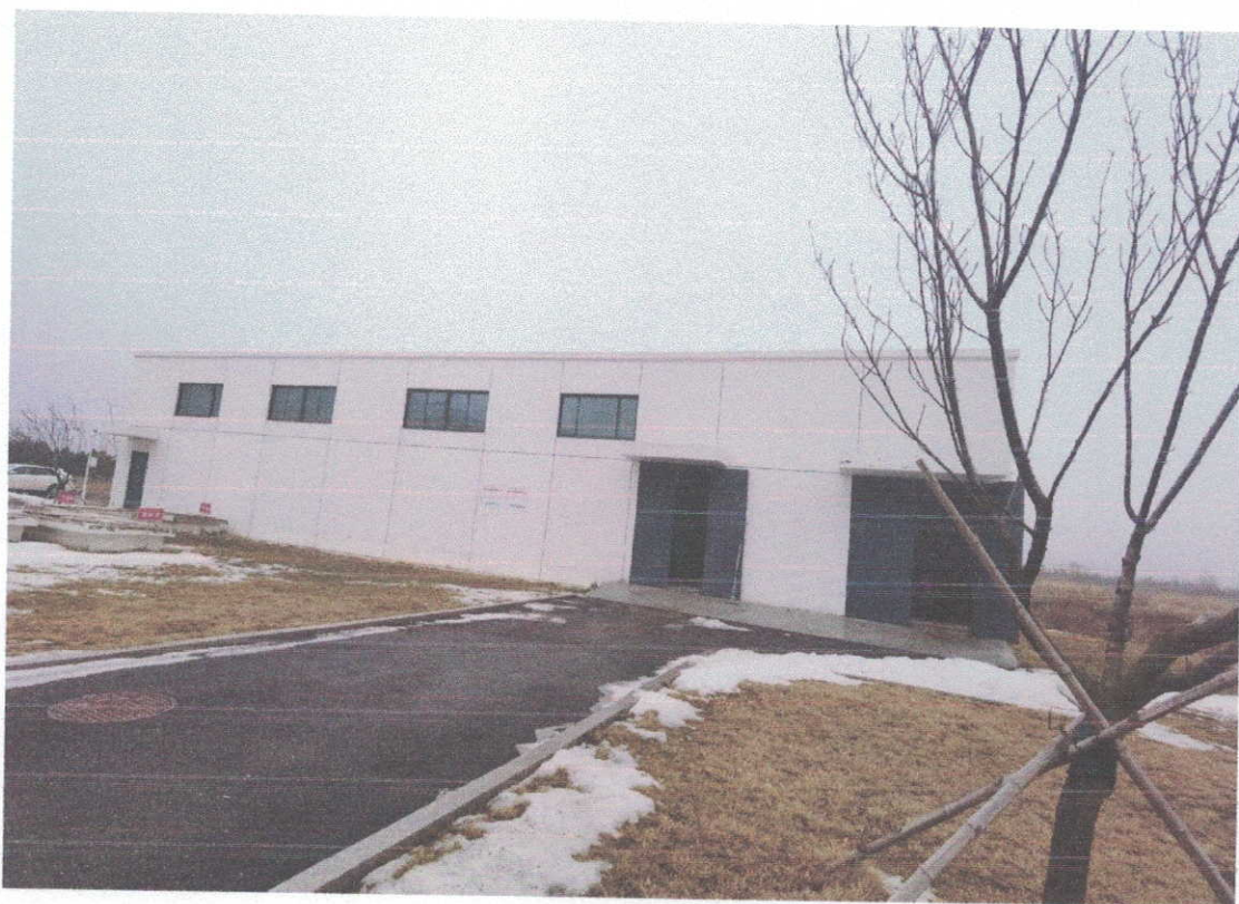
惠河路-90-19号污水处理站
